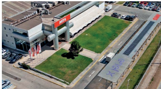
Planta Fotovoltaica y Estacionamiento Solar en MTS.
