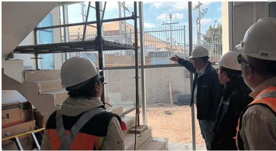
MOP ACUDIÓ A FISCALIZAR LA OBRA Y DESTACÓ QUE ESPERAN ENTREGAR EL EDIFICIO PARA SU EXPLOTACIÓN EN EL MES DE DICIEMBRE.
