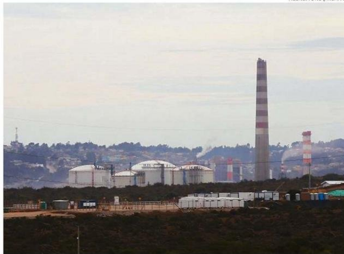
EL ABOGADO RECURRENTE REMARCÓ QUE HUBO UNA AFECTACIÓN IMPORTANTE EN LA ZONA.
