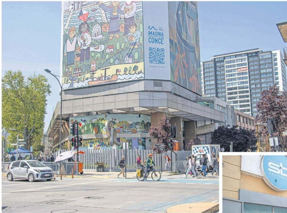
El edificio de la Caja Los Andes se encuentra cubierta por un mural de tela y enrejada en su perímetro.
