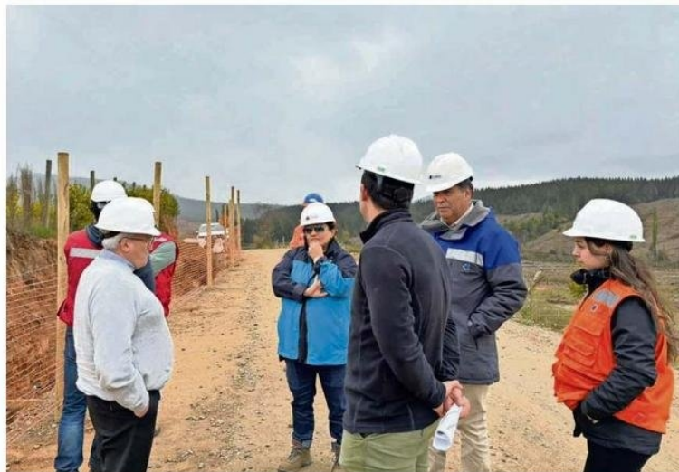
EQUIPO DE LA SUPERINTENDENCIA REALIZÓ INSPECCIÓN EN LAS OBRAS.
