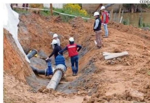
EXPLICAN QUE SE DEBE A OBRAS DE RENOVACIÓN.
