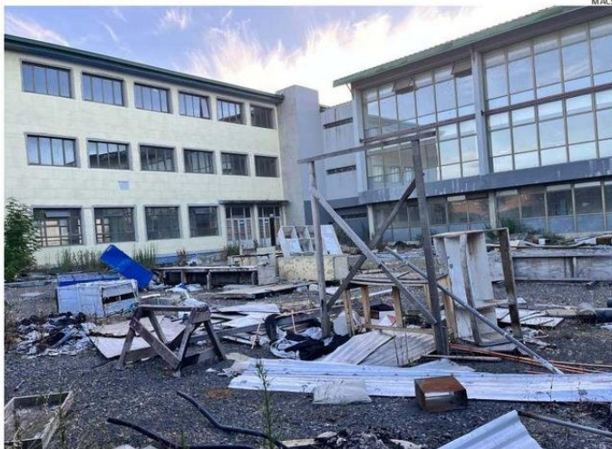
LAS OBRAS DEL LICEO CARMELA CARVAJAL LUCEN ABANDONADAS E INCONCLUSAS DESDE 2021.
