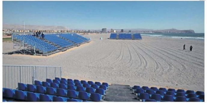
LAS ESTRUCTURAS PRINCIPALES YA SE ENCUENTRAN INSTALADAS.
