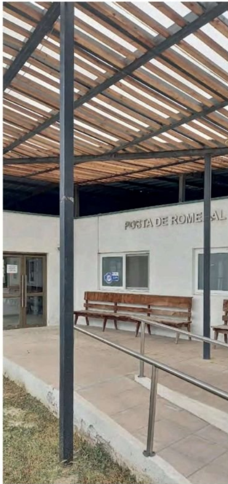
La actual y moderna Posta de Salud Rural de Romeral, donde ahora trabaja un completo equipo de salud primaria.
