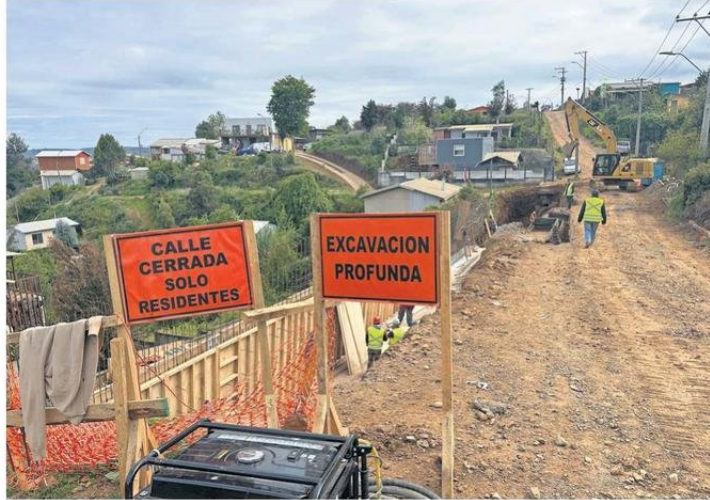
Los trabajos comenzaron el 7 de septiembre y demorarán siete meses.
