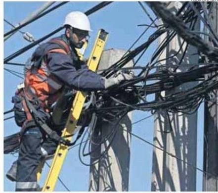
SÓLO EN ANTOFAGASTA FUERON DERRIBADOS 157 POSTES ELÉCTRICOS.
