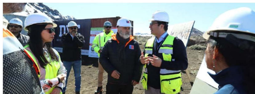
AUTORIDADES REGIONALES SE TRASLADARON a la zona de Antuco para comunicar el inicio de obras del complejo fronterizo.
