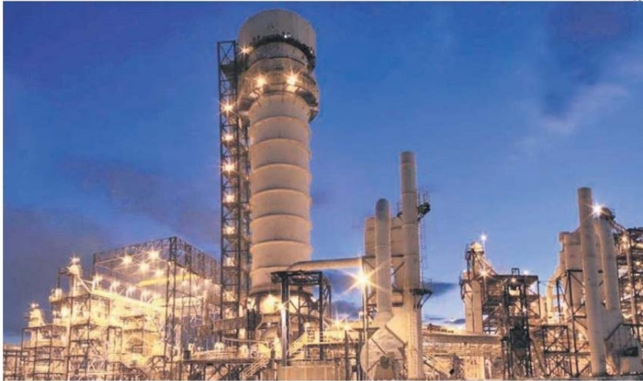
SQM INDUSTRIAL INGRESÓ EL PROYECTO MODIFICACIÓN DE LAS INSTALACIONES PRODUCTIVAS Y TRANSPORTE DE NITRATOS FAENA MINERA COYA SUR.
