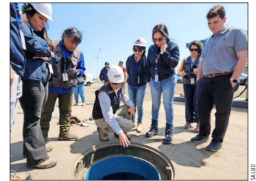
Inspecciones detectaron combustible en un sondeaje donde la sanitaria no almacena ese tipo de producto.
