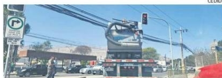
UNA IMAGEN DEMASIADO FRECUENTE EN COPIAPO: UN VEHÍCULO DE CARGA PASA A LLEVAR CABLES A BAJA ALTURA Y CON ELLO TERMINA CORTANDO UNO O VARIOS SERVICIOS BÁSICOS.
