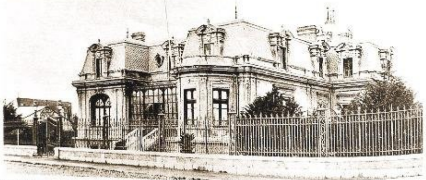
Residencia terminada, fotografía año 1910
