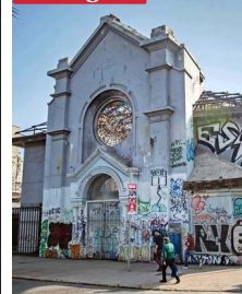
El fallo en primera instancia obliga al Estado a pagar cerca de $3 mil millones por los daños a La Asunción.
