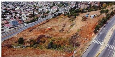
SE HA VISTO MOVIMIENTO DE TIERRA Y DE MAQUINARIAS EN EL TERRENO.
