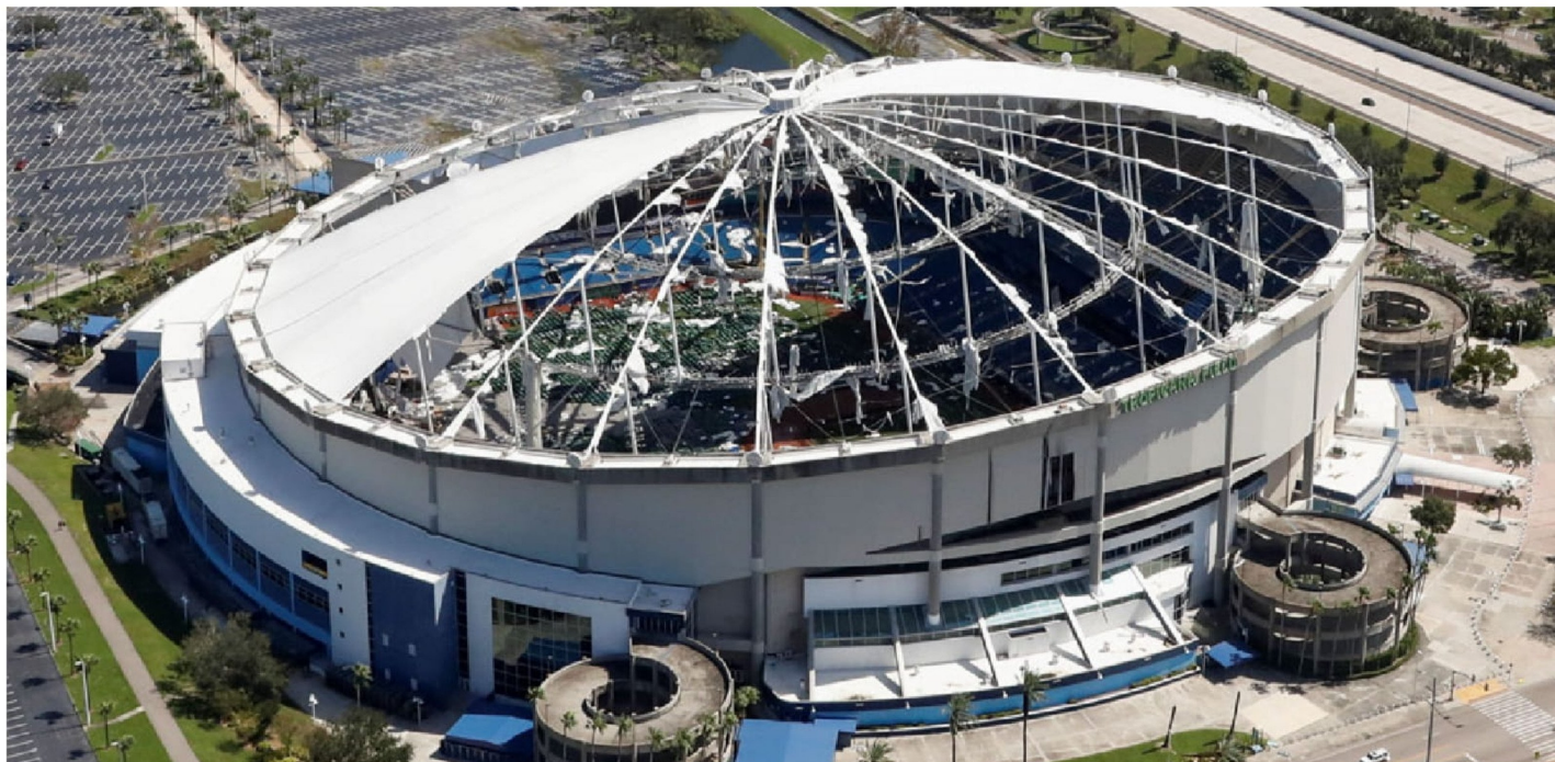
► Una vista aérea muestra el Tropicana Field, sede de los Tampa Bay Rays, dañado tras el paso del huracán Milton, en San Petersburg, Florida, el 10 de octubre de 2024.
