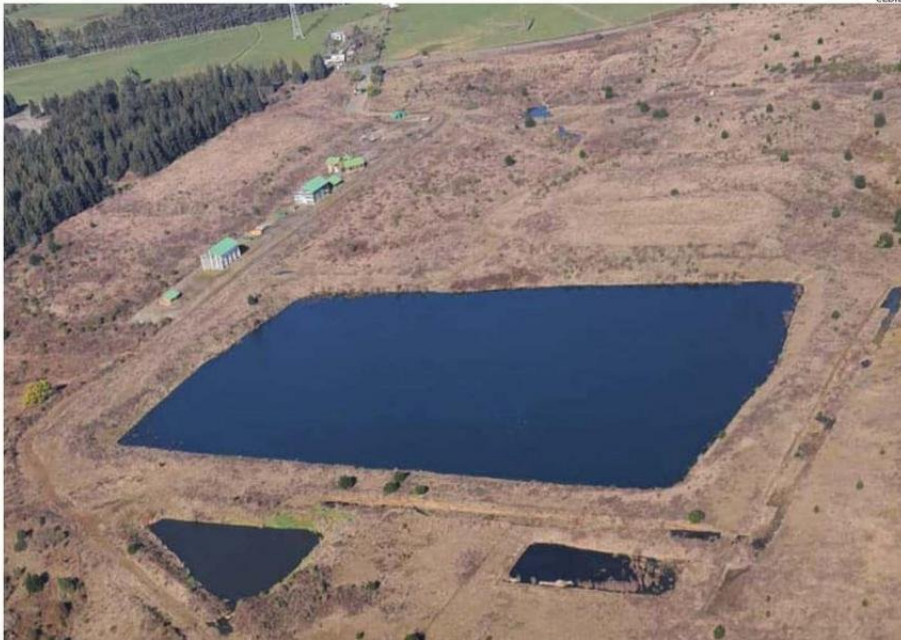
ASÍ LUCE EL ENORME AGUJERO DE LO QUE SERÍA UNO DE LOS ALVEOLOS DEL FALLIDO RELLENO. ESTÁ REPLETO DE AGUA Y SE DESCONOCE SI AÚN SIRVE.
