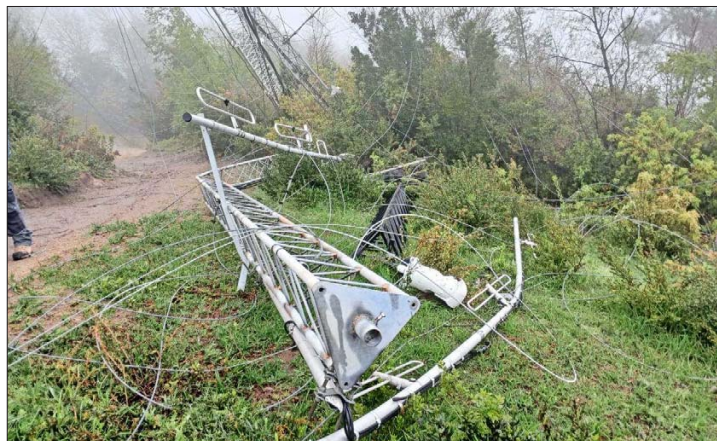
INSTALACIONES. — En la noche del domingo pasado, una torre de vigilancia forestal fue derribada en la comuna de Florida, en Biobío. El jueves, en el límite de esa zona con Hualqui y Yumbel, una caseta con equipos fue asaltada.
