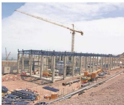
LA INICIATIVA LLEVA MÁS DE UN 40% DE AVANCE EN SUS OBRAS.
