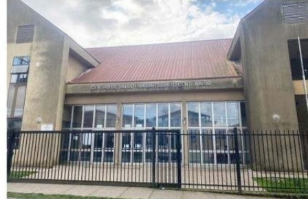
EL CESFAM HA QUEDADO SIN LUZ DURANTE FINES DE SEMANA COMPLETOS.
