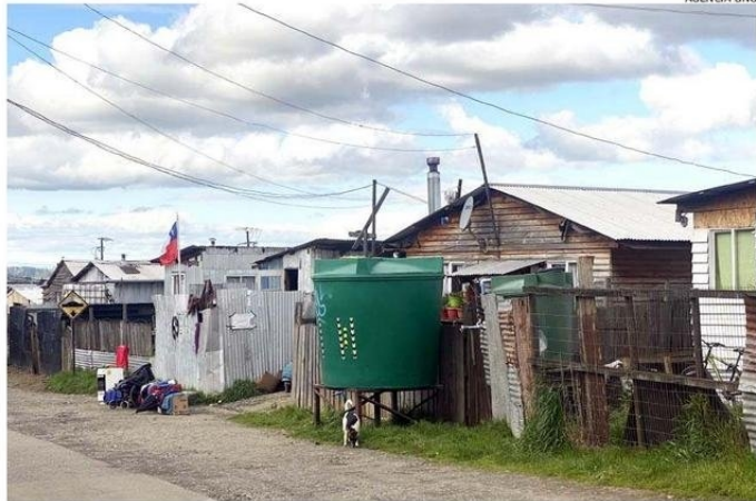
A SIMPLE VISTA SE PUEDE VER LA GRAN CANTIDAD DE CONEXIONES ILEGALES QUE VIENEN DE LA TOMA.
