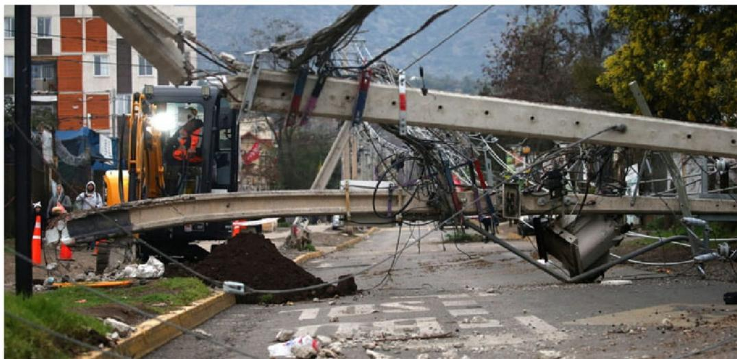
locidades superiores a los 120 km/h, comparables a un huracán de categoría 1, según la escala Saffir-Simpson. Este fenómeno superó los estándares de diseño de las líneas eléctricas, diseñadas para resistir vientos de hasta 91 km/h.
