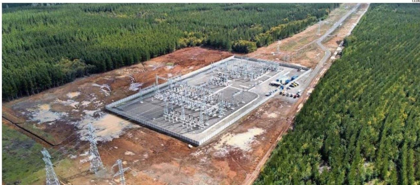
INVERSIÓN DE LA INFRAESTRUCTURA SUPERÓ LOS US$20 MILLONES DE DÓLARES.
