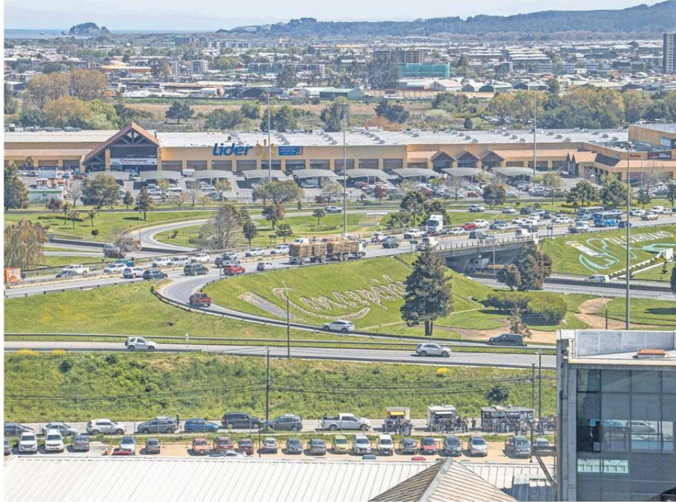
El Enlace Trébol se ubica en el cuarto puesto de las áreas críticas del Gran Concepción, antecedido por la Av. Costanera y el Nudo Nobis.
