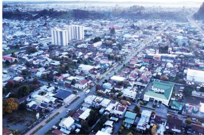
OSORNO TIENE 3 POLÍGONOS DE FISCALIZACIÓN: LAS QUEMAS-BELLAVISTA, PILAUCO Y CENTRO EXTENDIDO.
