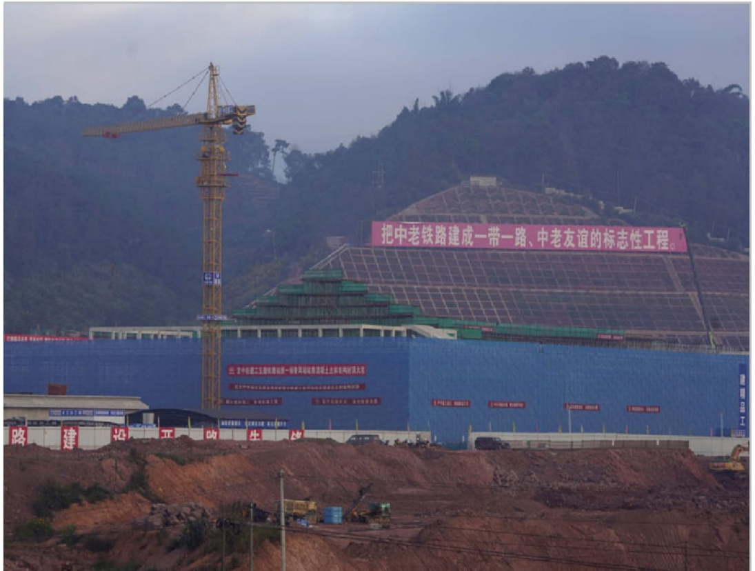
► Sitio de construcción de la estación de alta velocidad de la ciudad de Pu'er, parte de la línea ferroviaria China-Laos.
