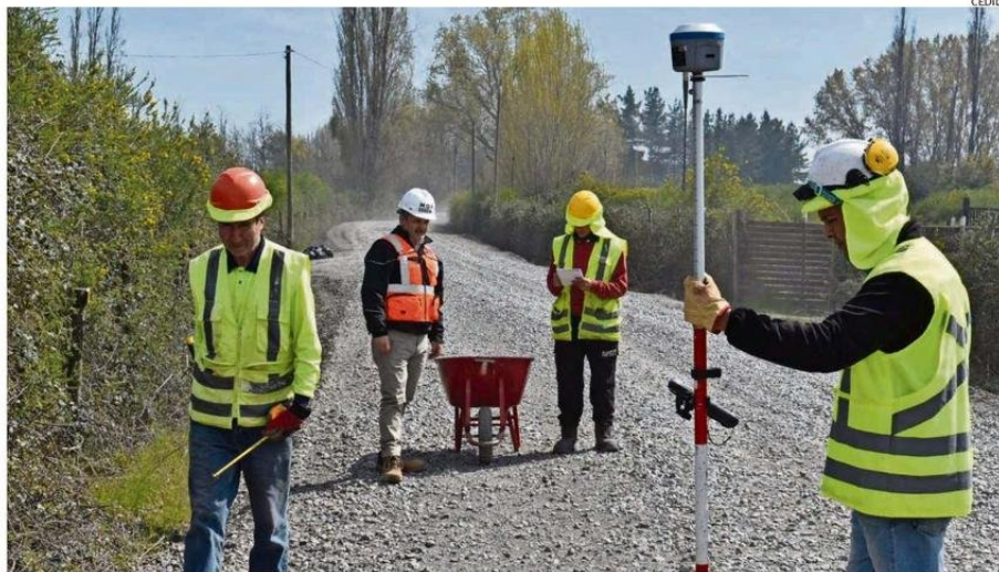
VECINOS VALORARON EL COMIENZO DE LOS TRABAJOS DE PAVIMENTACIÓN DE LA RUTA DE LA COMUNA DE COIHUECO.
