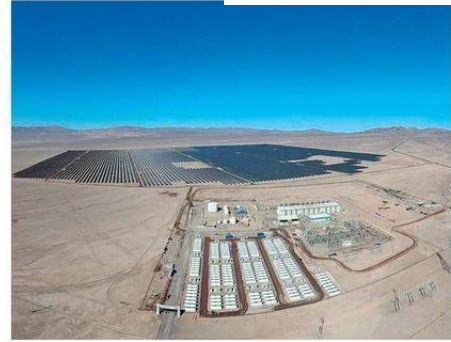
BESS TAMAYA SE ENCUENTRA ACTUALMENTE EN FASE DE PRUEBA.
