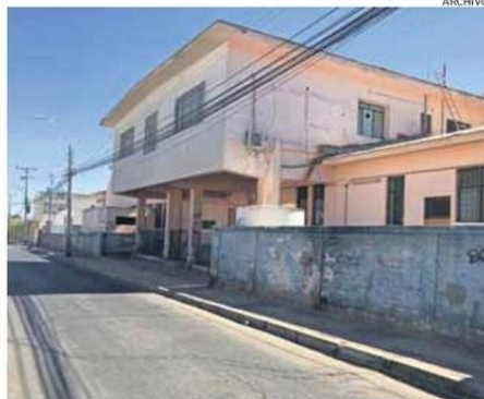
LAS INSTALACIONES DEBEN SER SANEADAS TRAS SU DEMOLICIÓN.
