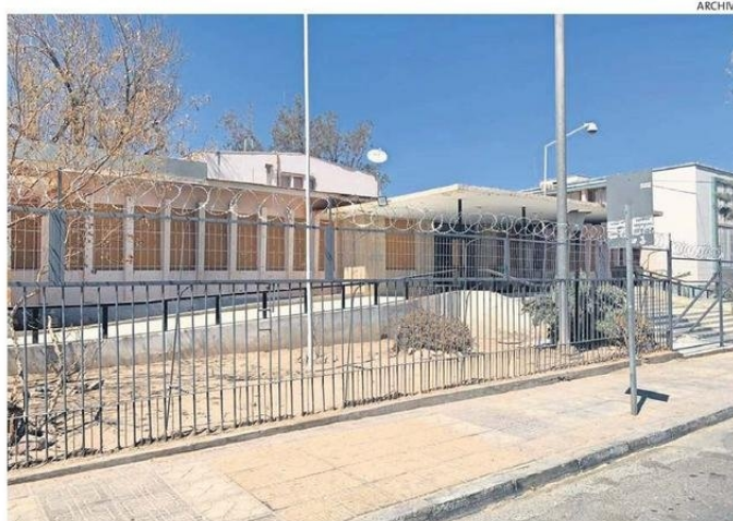
DE ACUERDO A LO INFORMADO POR EL SERVICIO DE SALUD, EL EXCENTRO ASISTENCIAL DEBE SER DEMOLIDO DURANTE EL PRÓXIMO AÑO.
