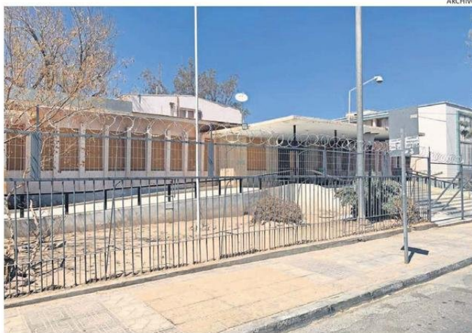
DE ACUERDO A LO INFORMADO POR EL SERVICIO DE SALUD, EL EXCENTRO ASISTENCIAL DEBE SER DEMOLIDO DURANTE EL PRÓXIMO AÑO.
