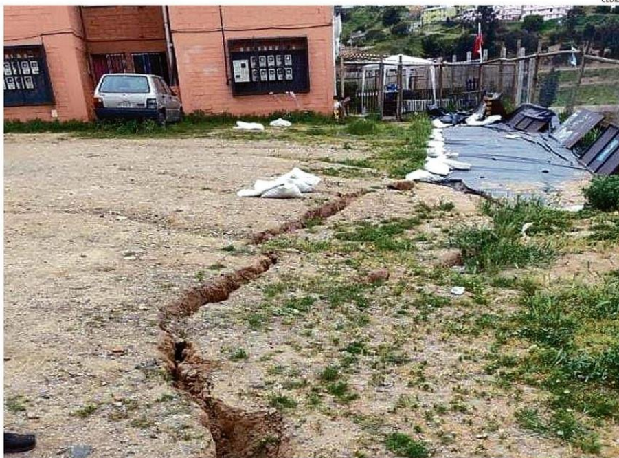
HACE MÁS DE TRES MESES QUE APARECIERON LAS GRIETAS Y ESTÁN A LA ESPERA DEL PRONUNCIAMIENTO DEL SERVIU TRAS UN INFORME.
