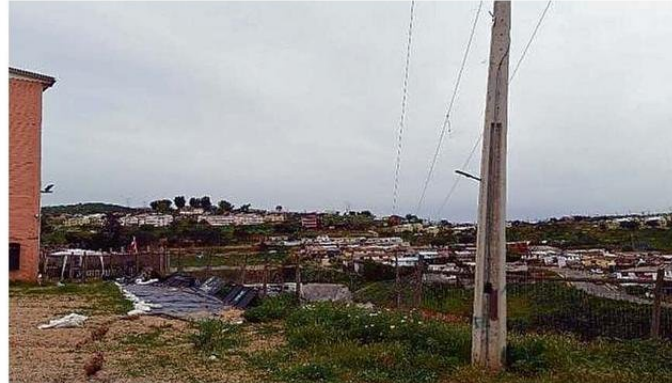
ADEMÁS DE CASAS, LAS GRIETAS PODRÍAN AFECTAR POSTES DE LUZ.
