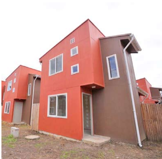
En San Carlos viviendas sociales terminadas no tienen energía eléctrica.
