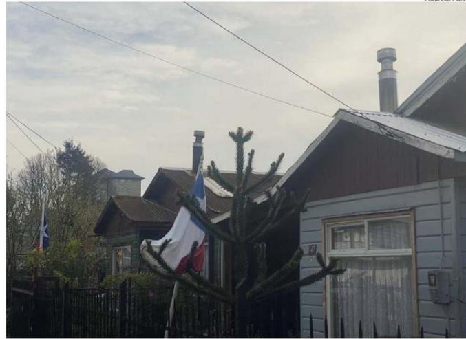
EXPERTOS CONSIDERAN NO HA HABIDO AVANCES EN RECAMBIO DE CALEFACTORES O LA MEJORA TÉRMICA.
