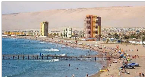
ANTES. — Estos muelles estaban hasta el siglo pasado en la costa. Parte de sus estructuras bajo al agua son un riesgo para bañistas y surfistas.
