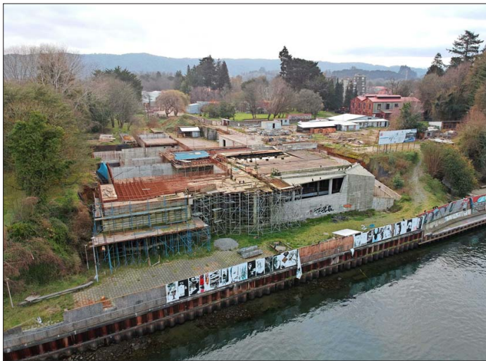
TRABAJOS.— El MAC de Valdivia se erige en el sector de Isla Teja. Ahora, la Contraloría deberá definir si las obras pueden continuar o no.
