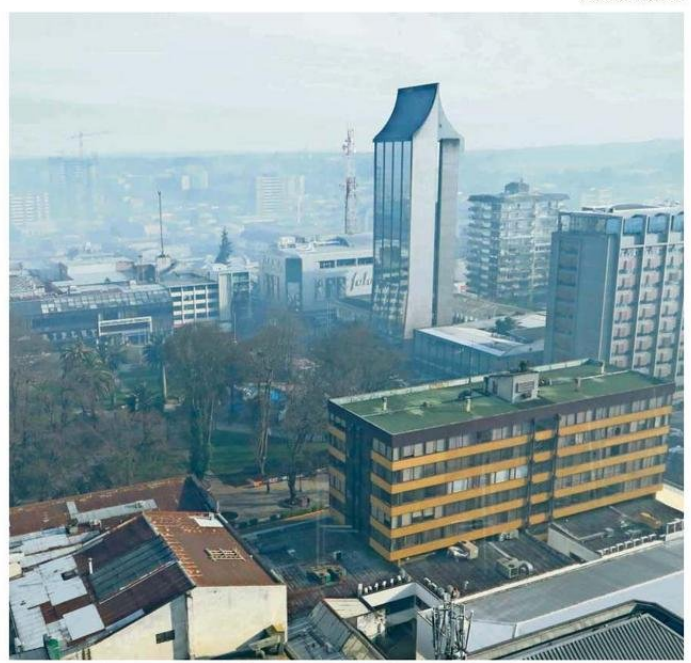
DURANTE LA ACTUAL TEMPORADA GEC, SE REALIZARON 789 FISCALIZACIONES EN TODA LA INTERCOMUNA.
