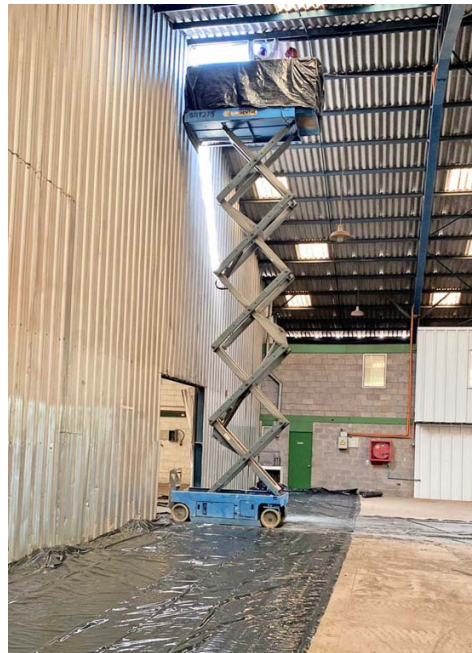
Tratamiento de asbesto no friable.
