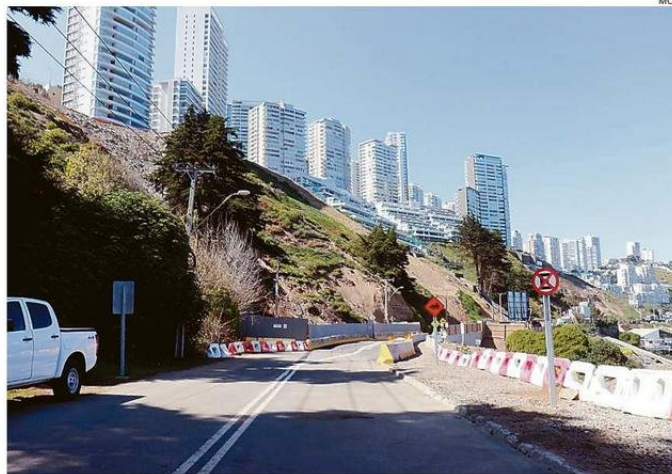
EL MOP ESTIMA QUE LOS TRABAJOS VAN A SUPERAR LOS $10.150 MILLONES PRESUPUESTADOS INICIALMENTE.
