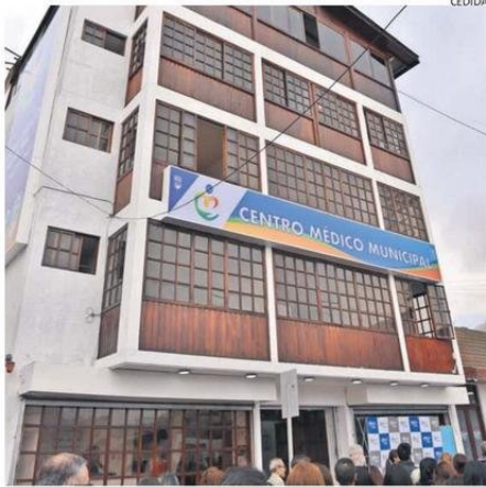
EL CENTRO MÉDICO ESTA UBICADO EN LATORRE #458.
