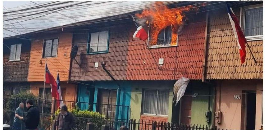
LAS VIVIENDAS DE RAHUE DOS FUERON CONSTRUIDAS EN 1958, SIN CORTAFUEGOS. POR ESO EL INCENDIO DEL 19 DE SEPTIEMBRE DAÑÓ CINCO CASAS.
