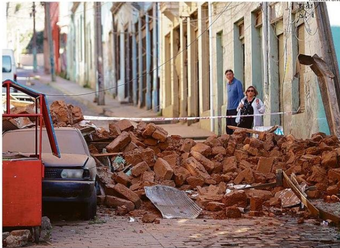
EL PASADO DOMINGO 9 DE SEPTIEMBRE SE DERRUMBÓ UNA CASA EN EL CERRO TORO, DEJANDO 16 AFECTADOS.
