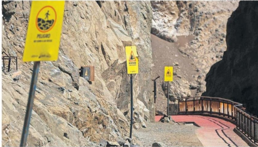
EL SECTOR SE ENCUENTRA CERRADO INDEFINIDAMENTE POR RAZONES DE SEGURIDAD PARA LOS VISITANTES.
