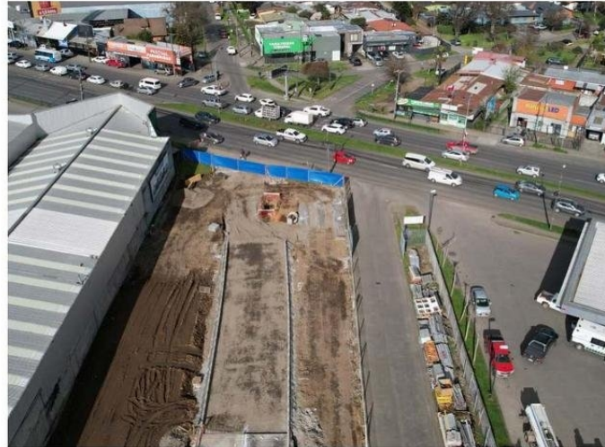
FUE DESARMADO EL GALPÓN UBICADO ENTRE EL SERVICENTRO COPEC Y LA AUTOMOTORA CASTILLO.
