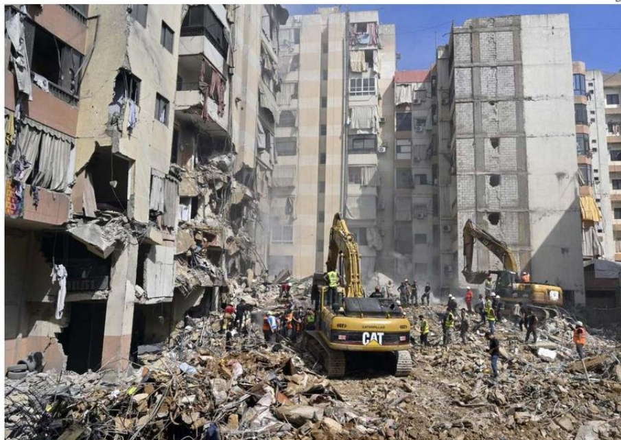
CON EXCAVADORAS LIMPIABAN AYER LOS ESCOMBROS EN EL LUGAR QUE FUE BLANCO DEL ATAQUE ISRAELÍ EL VIERNES, EN EL SUBURBIO AL SUR DE BEIRUT.
