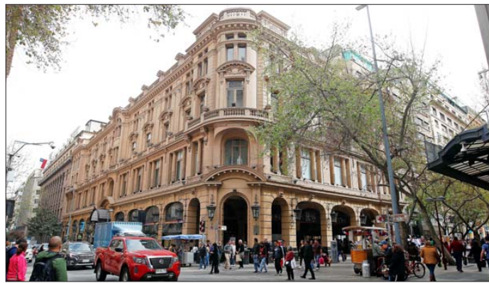
El edificio del ex Hotel Crillón fue construido entre 1917 y 1919. Durante décadas, el hotel fue uno de los principales centros de reunión social de la capital.
