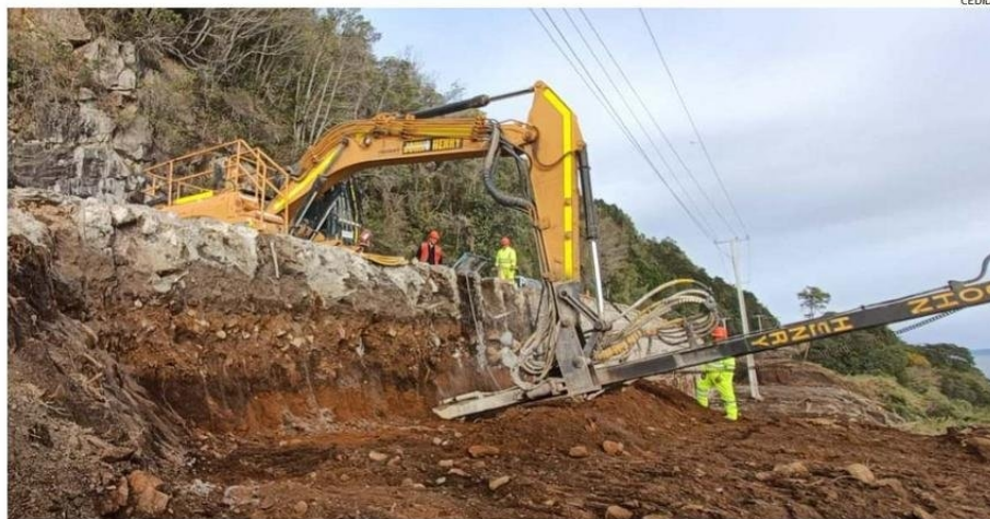
SE CONSTRUYE UN MURO CORTINA DE HORMIGÓN DE SHOTCRETE CON MICROPILOTES, MÁS DOS NIVELES CON PERNOS DE ANCLAJE POSTENSADOS.
