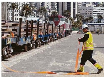
EL TRASLADO DEL MATERIAL SE REALIZÓ POR MODO FERROVIARIO.
