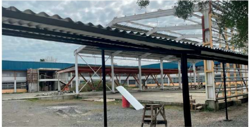
EL MUNICIPIO TAMBIÉN está abordando el retiro de escombros y otros materiales dejados por la empresa constructora, mientras se prepara para la próxima fase del proyecto.
